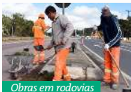
Obras em rodovias
